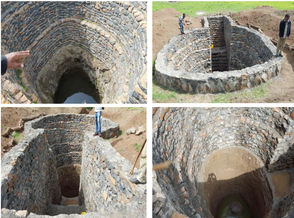
ምስል 7 ውስጣዊ ግድግዳው በድንጋይ የተሸፈነ እና የመግቢያ ደረጃ የተሰራለት የእጅ ጉድጓድ (ሁመራ አካባቢ)
