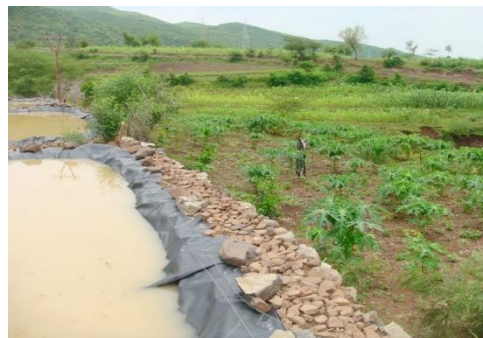
ሰሜን ወሎ ዞን፤ ጉባላፍቶ ወረዳ ገራዶ ቀበሌ ክትልቅ ወደትንሽ በቅደም ተከተል የተደረገፍ በፕላስቲክ የተሸፈኑ ስምንት ኩሬዎች
