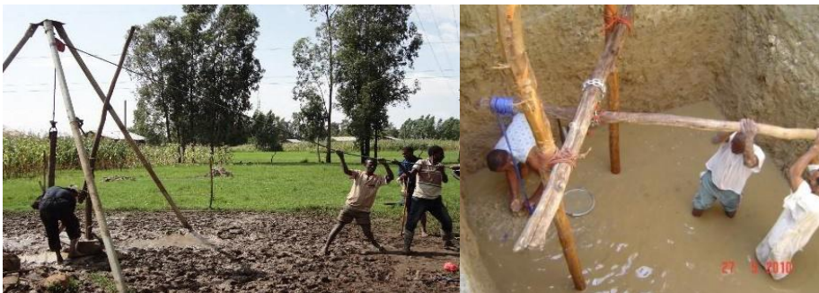
ምስል 1 የአፈር ማለስለሺያ መዶሻና ፈሳሽ ደለል በመፍጠር የሚካሄድ ቁፋሮ
