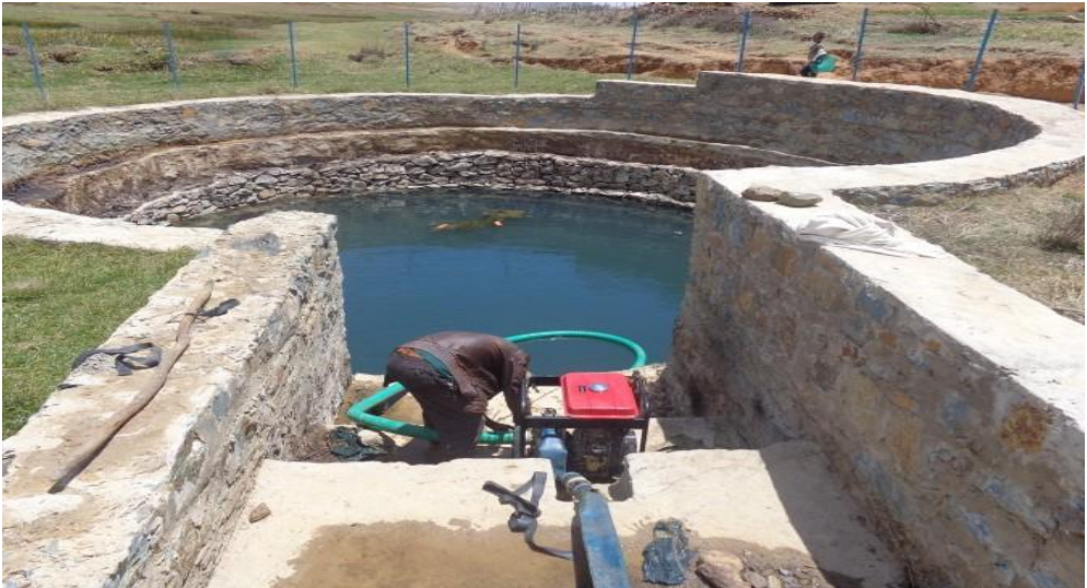
ምስል 12 በትክክለኛ የውኃ መምጣጫያ ከፍታ ላይ የተቀመጠ አነስተኛ ፓምፕ
