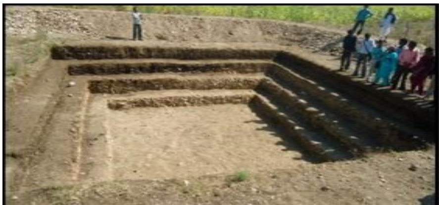
ምስል 17: ኩሬን ደረጃ በደረጃ መቆፈር፣ ጥልቀት መጨመር እና የኩሬውን ውስጣዊ አካል ቅርፅ ማውጣት
