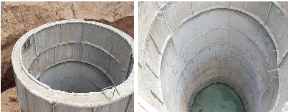
ምስል 8 የእጅ ውኃ ጉድጓድ ግንባታ ወቅት የሚያጋጥምን መደርመስ ለመከላከል በቀለበታማ የኮንክሪት ቱቦ ውስጣዊ ግድግዳውን መሸፈን
