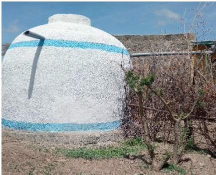
ምስል 24፡ ከጣሪያ ውኃ ለማጠራቀም ከምድር በላይ እና ከምድር ውስጥ የተገነቡ ገንዳዎች
